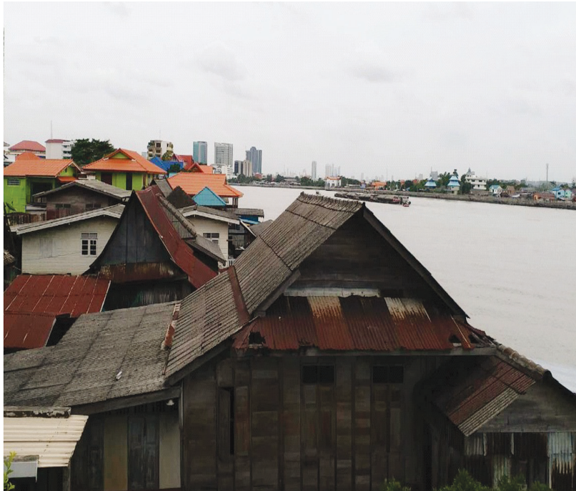
รูปที่ ๔ หลังคากระเบื้องโยหินอายุใช้งานเกิน ๔๐ ปี
